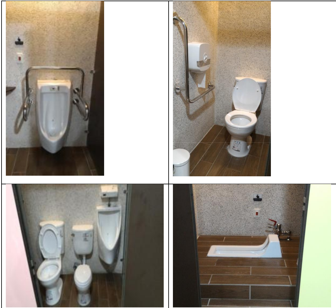
圖三 針對不同使用於不同廁間設置不同便器。(來源：內政部建築研究所，2015)
